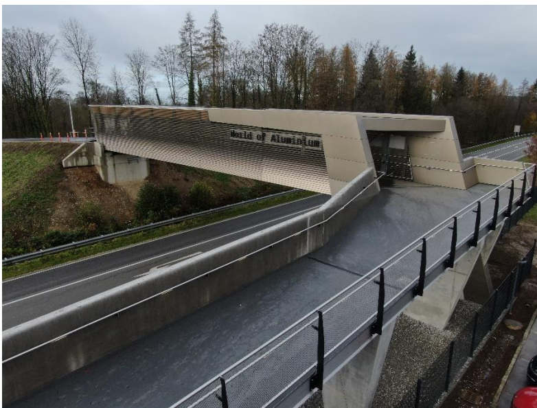
Bild 3: Der AMAG Rad- und Fußgängerübergang im modernen und innovativen Design. (©AMAG)
