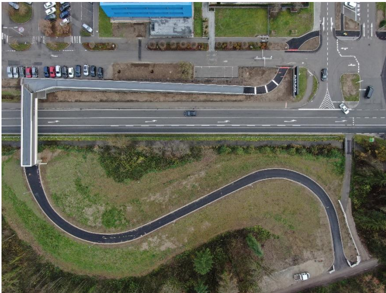
Bild 2: Der Rad- und Fußgängerübergang ist an das übergeordnete Radwegenetz angebunden. (©AMAG)
