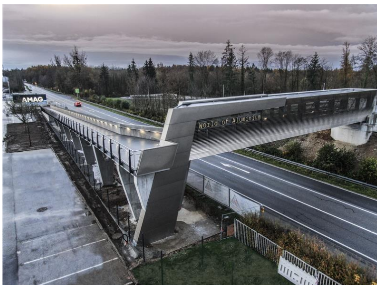
Bild 1: Der Rad- und Fußgängerübergang bietet ein sicheres Überqueren der Landesstraße. (©AMAG)
