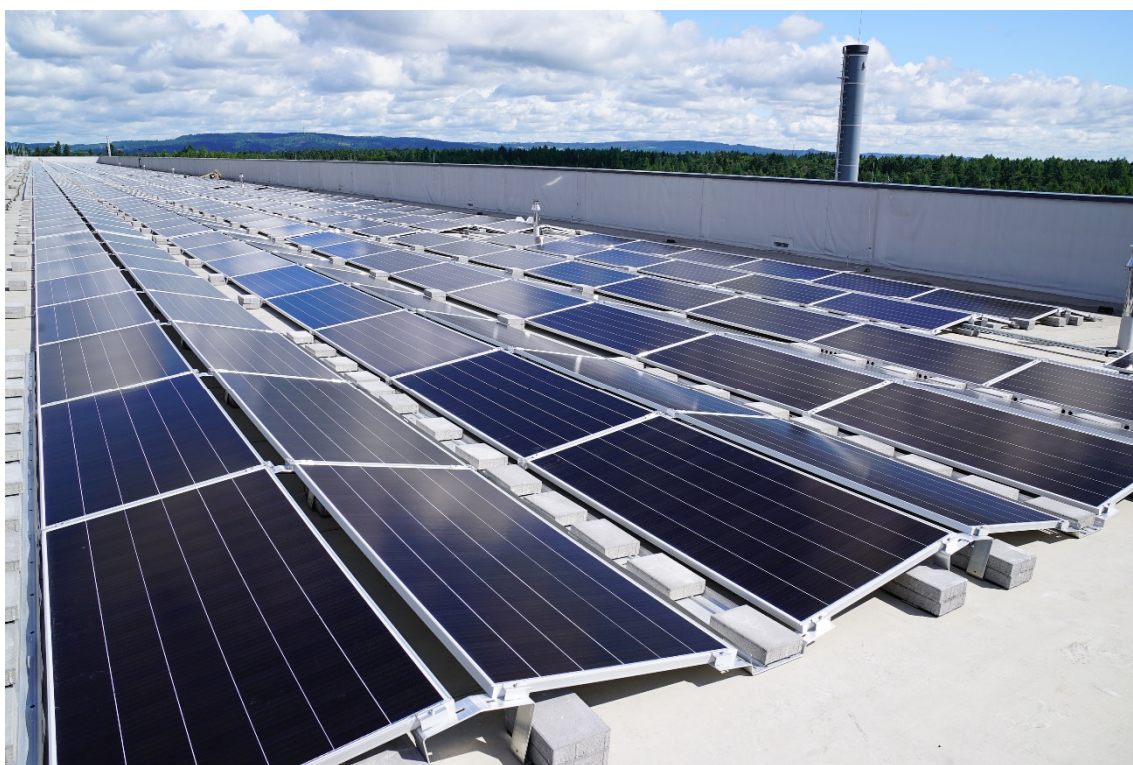
Bild 3: Ein Blick auf das Dach (© AMAG)
