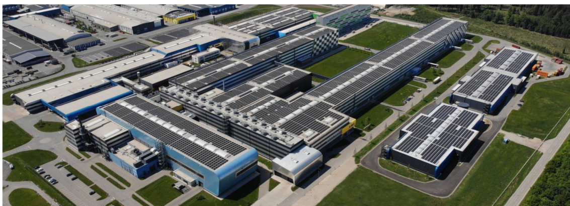
Bild 2: 60.000 m 2 Photovoltaikanlage auf den Dächern des neuen AMAG Werks produzieren 7,3 GWh elektrischen Strom pro Jahr (© AMAG)
