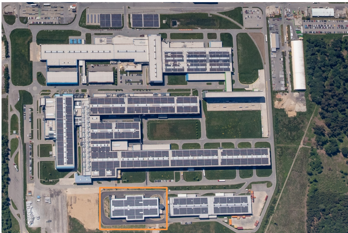
Bild 1: PV Anlage auf den Dächern des neuen AMAG Walzwerks inkl. Erweiterungsfläche auf der neuen Logistikhalle (oranger Rahmen) (© AMAG)
